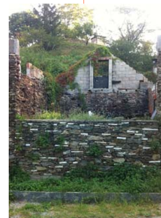
Fase della costruzione: le fasi di costruzione della copertura
